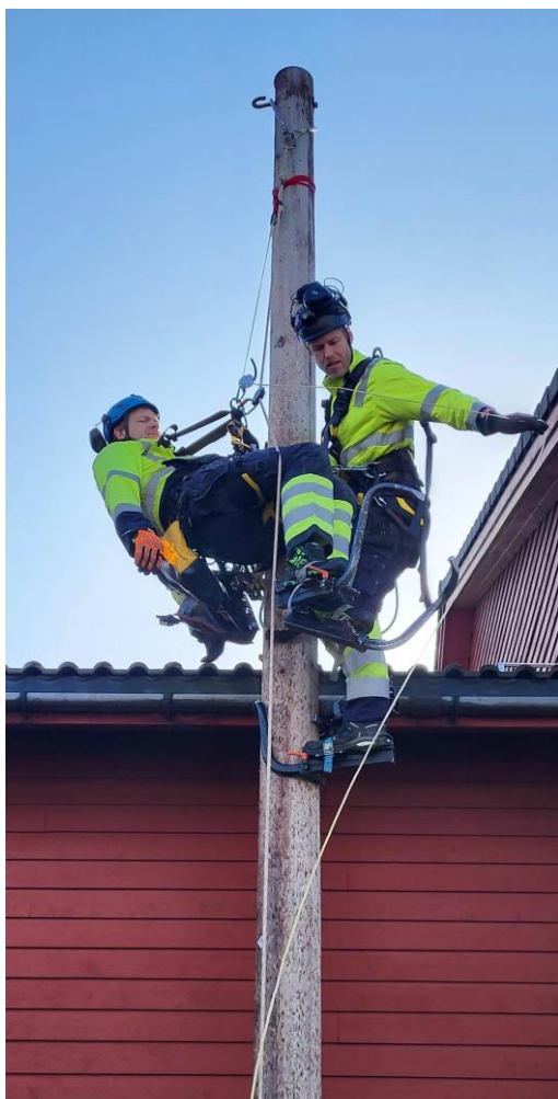
Øving på berging av skadd kollega fra stolpe
