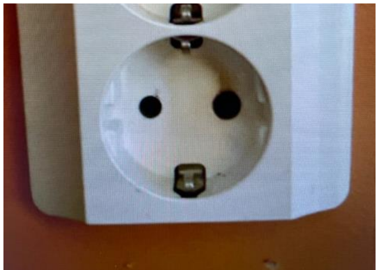
Plugg og stikkontakt til varmtvassberedar med tydelege teikn til varmgang. Avdekket på kontroll av DLE
