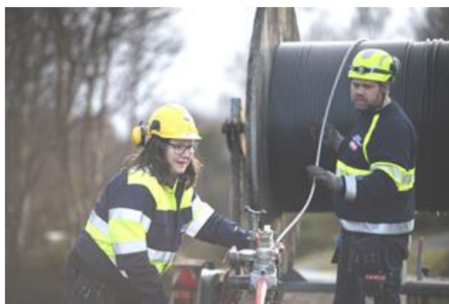
Arbeid med fiberkabel
